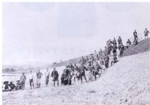
天竜川築堤工事（明治時代）
