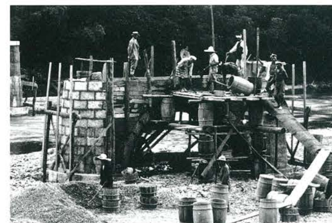
気田川 菰橋 橋脚工事
